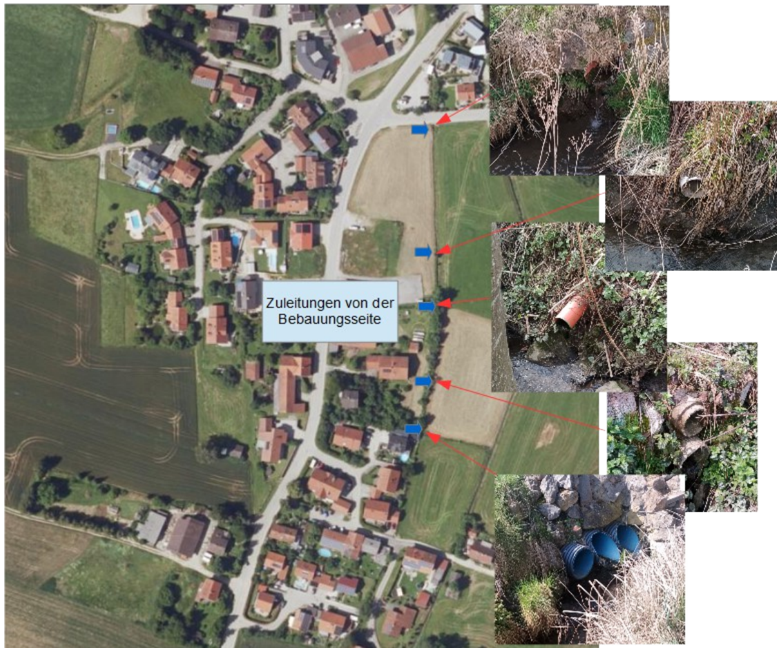
Abbildung 4: Lage der gefundenen Zuleitungen im Untersuchungsabschnitt (Abbildungsgrundlage - Luftbild Umweltatlas Bayern 2025).
