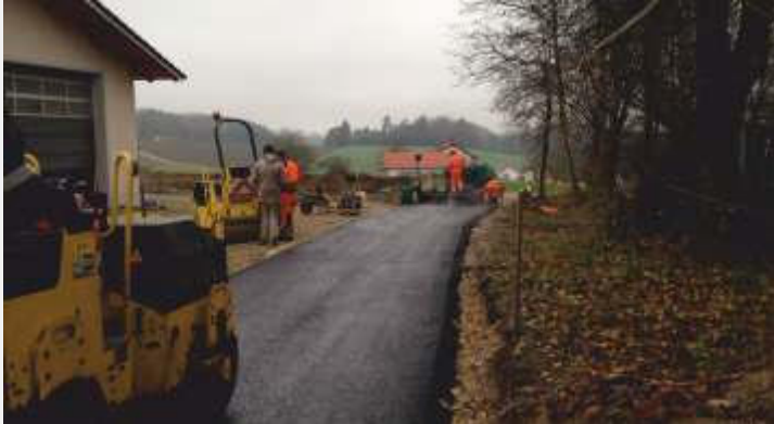
Die Asphaltierungsarbeiten in Kienrathing
