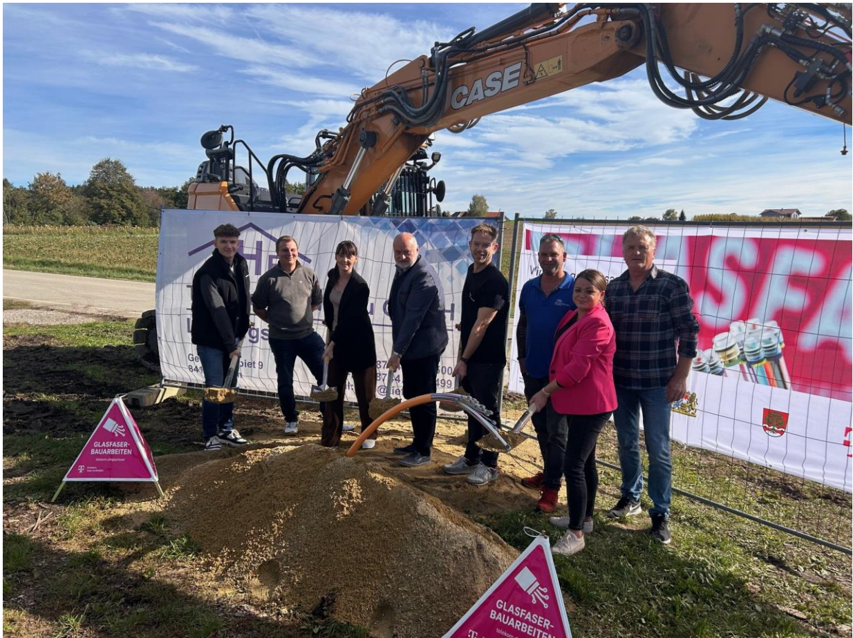
Auf dem Foto von links nach rechts: Hr. Bobenstetter (Bauamt Buchbach) Hr. Offensberger (Telekom Technik) Fr. Schubert (Telekom Technik) Hr. Einwang (1. Bürgermeister Buchbach) Hr. T. Pflügl (Tiefbaufirma THB) Hr. E. jun. Pflügl (Tiefbaufirma THB) Fr. Schäfer (Kommunalberaterin, Telekom Deutschland) Hr. Stoiber (Technisches Bauamt Buchbach) Bildrechte: Telekom
